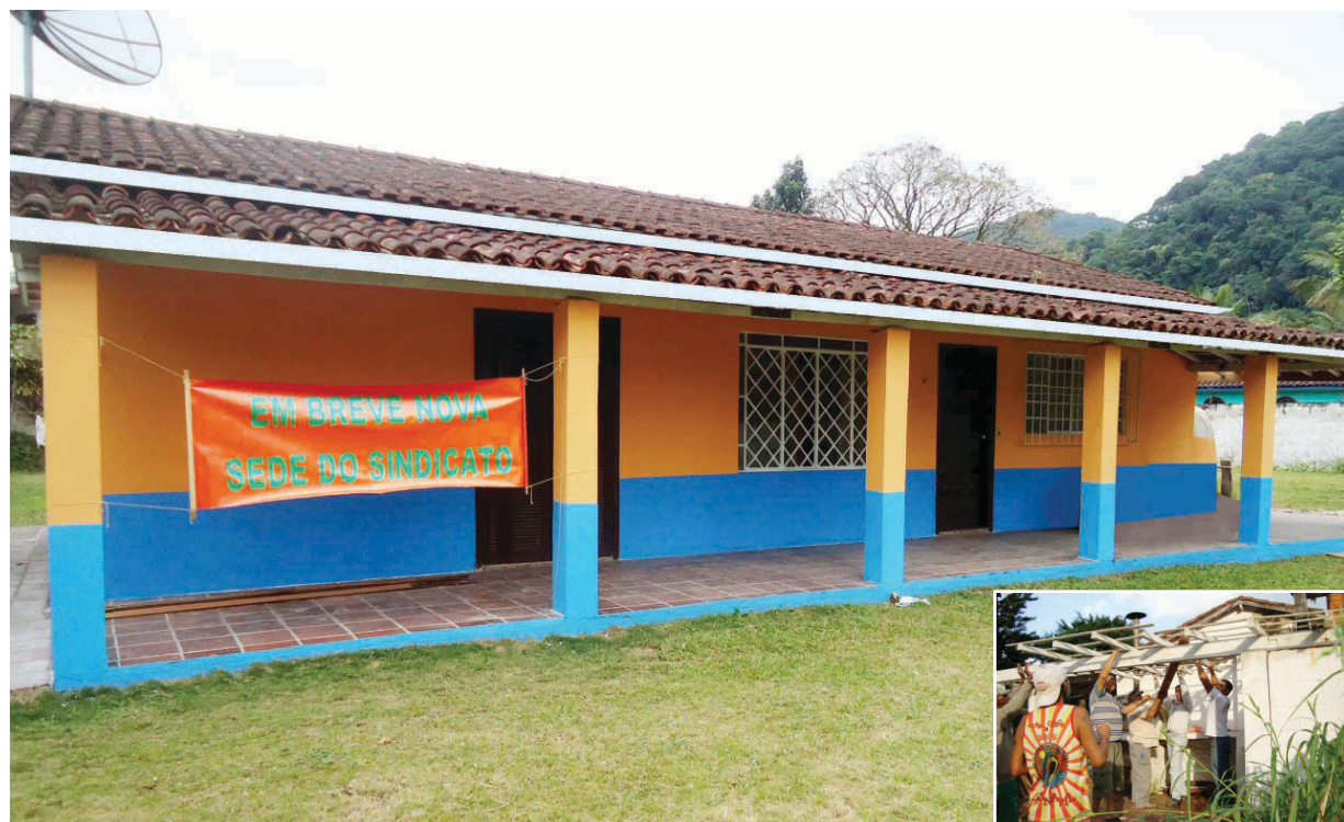
Casa recebe adequações estruturais e pintura. No detalhe, mutirão de limpeza feita por servidores
